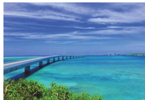
伊良部大橋（伊良部地区）
