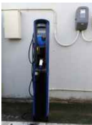
図 3-2 設置した充電器
