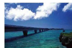
島々を結ぶ大橋（池間大橋）
