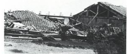
昭和41年のコラ台風で倒壊した木造住宅 資料：ひら（平良市制施行40周年記念誌）
