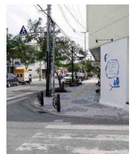
電柱地中化や街路樹の設置等の整備された市場通り
