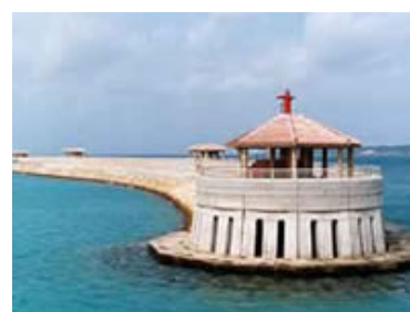
港内側先端より堤頭部を望む 平良港湾事務所HPより
