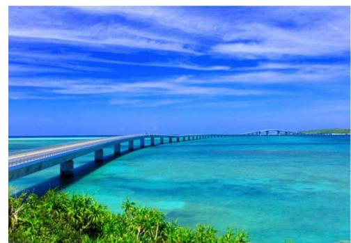
伊良部大橋（伊良部地区）
