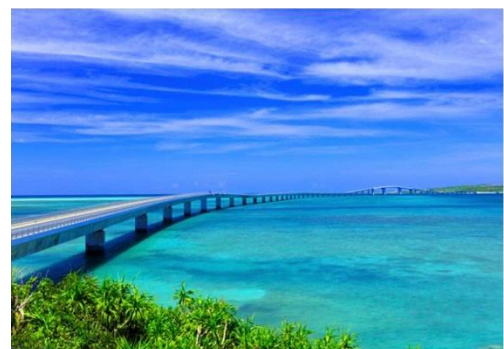
伊良部大橋（伊良部地区）
