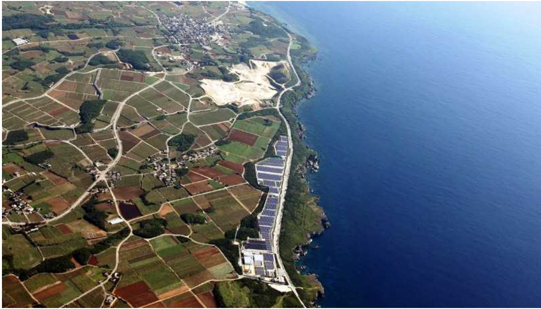
【沖縄電力のメガソーラー施設（城辺字保良）】
