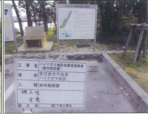
海岸施設案内板の設置
