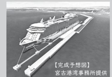
『国の国際旅客船拠点形成港湾』に指定されている平良港に、14万トン級のクルーズ船が停泊できる長さ370mの岸壁の整備が進められており、今年春頃の供用開始が予定されています。
