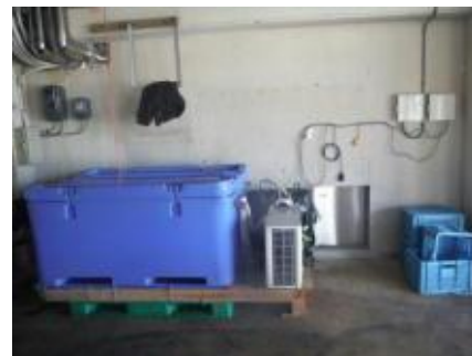
設置完了後の様子
