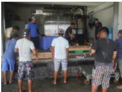
設置作業の様子
