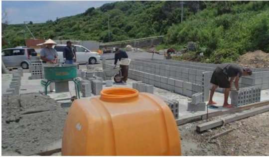
施設整備作業の様子
