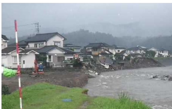
河岸侵食による家屋の倒壊(花月川)
