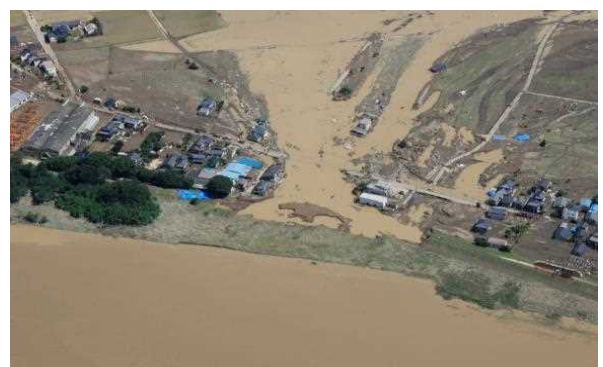
堤防決壊による家屋の流失(鬼怒川)
