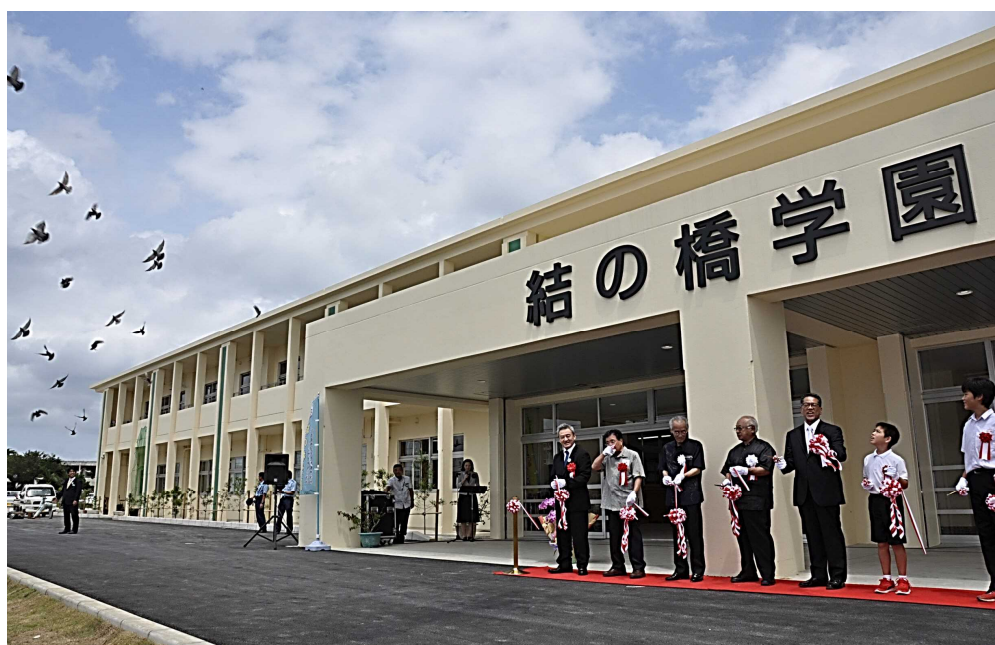
宮古島市立小中一貫教育校 伊良部島小学校・伊良部島中学校 愛称「結の橋学園」
