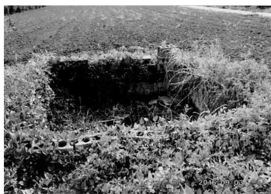
写真 6. 耕作地の吹田 ・ブロックで囲まれたところが噴出口である。
