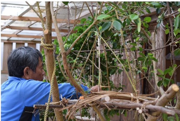
5 床の中央にススキで小屋の骨組みをつくる。
