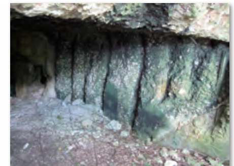
鉄筋を抜かれたコンクリート壁
