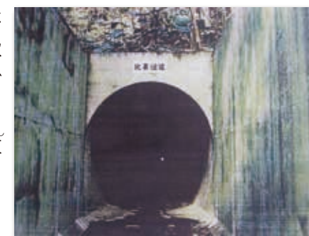
直径5mで、ダンプ1台がゆいに通れる大きさの新トンネルが瑞福隧道と並行して走る
