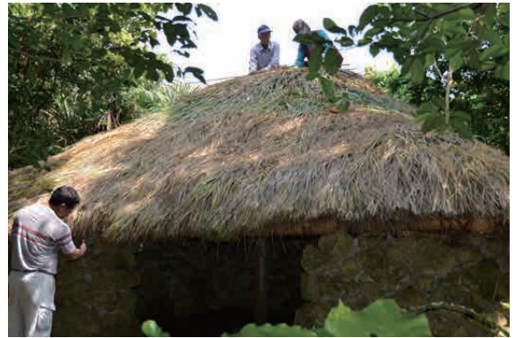
写真 106 平成 27 (2015) 年時のウイウスムトゥの屋根の茅葺き替え工事風景
