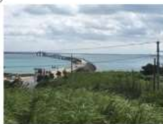
海の駅、第2駐車場より。
