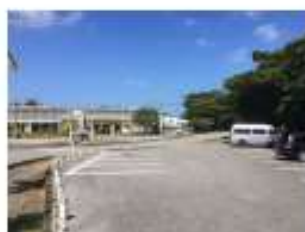
現在、入口周辺3カ所に乗用車40台、バス5台分の駐車場がある。クルーズ船寄港時にはバス駐車場が不足。
