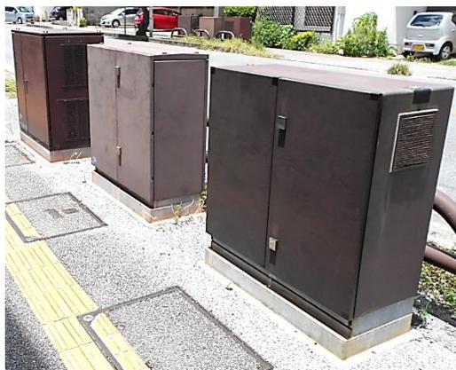
写真 5-1 電線共同溝方式による無電柱化
