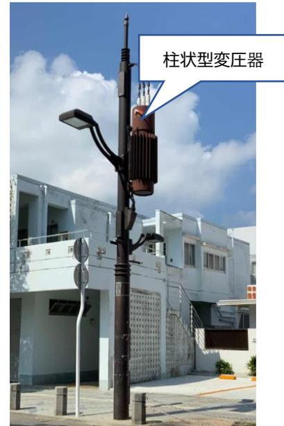
写真 5-2 ソフト地中化による無電柱化
