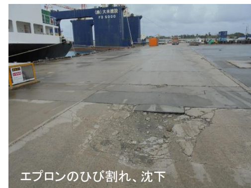
【施設の老朽化の状況】
