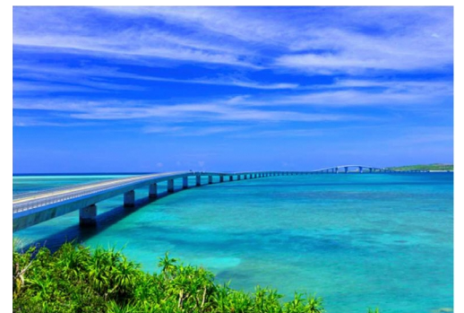
伊良部大橋（伊良部地区）
