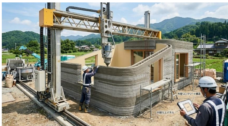
※施工イメージ
