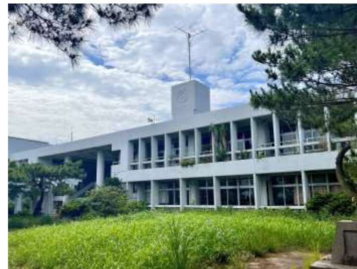
旧上野庁舎外観
