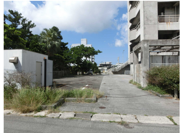
西側駐車場入口（南側より）
