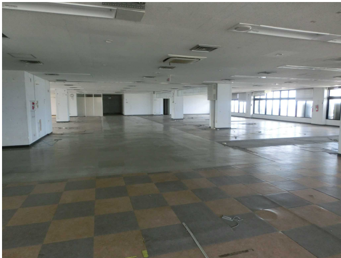
4階全体（東側より）
